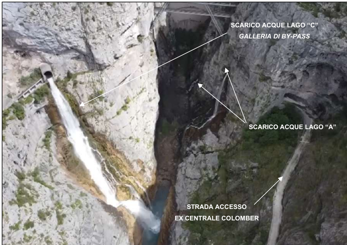
Figura 62: Ripresa aerea della forra: si può notare l'enorme pozza (pool) presente ai piedi della cascata.
