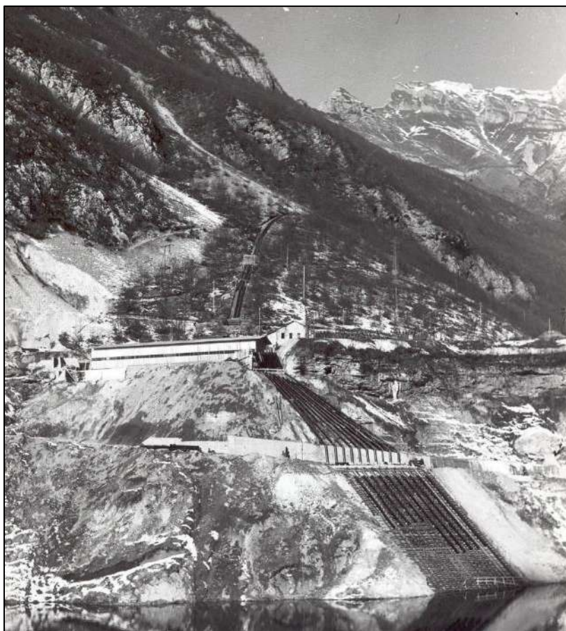
Figura 29: L'impianto di pompaggio (inverno 1963/64).
