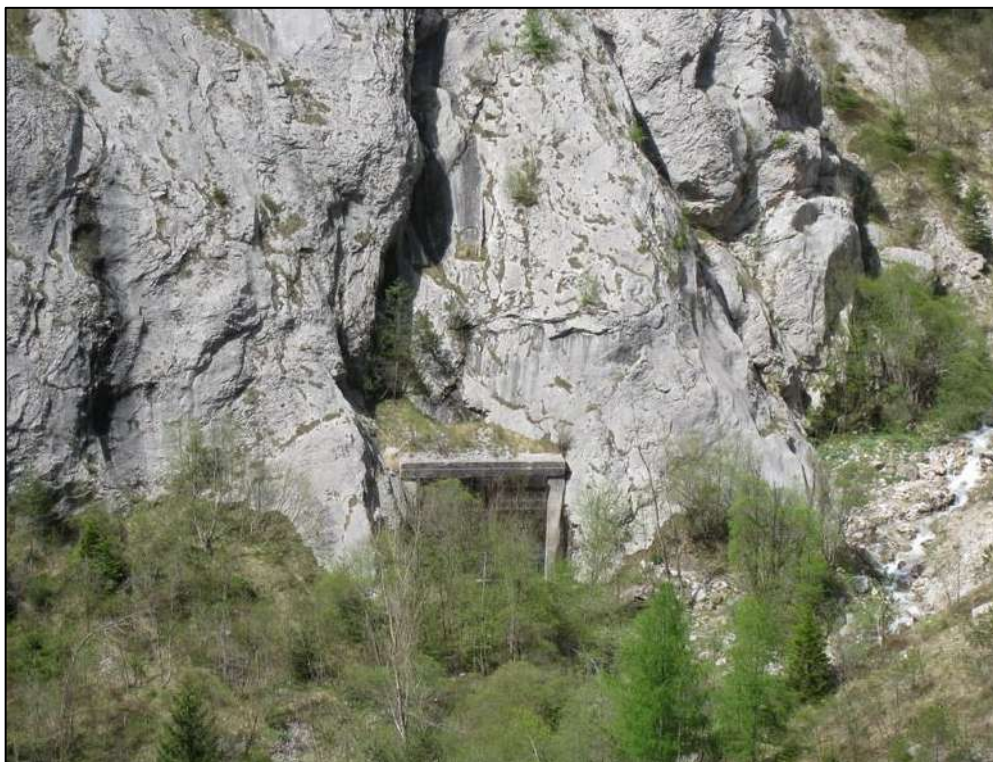
Figura 32: Imbocco sussidiario attivo galleria a quota 675 m s.l.m.
