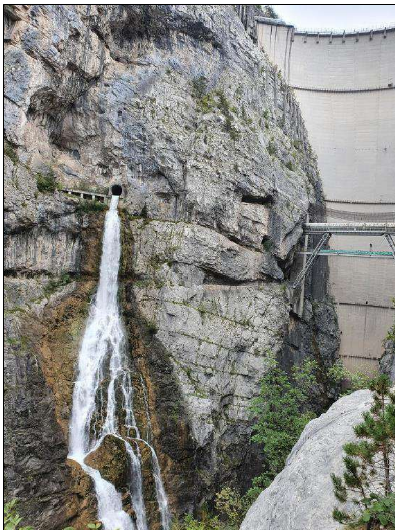
Figura 17: Punto di sbocco della galleria di sorpasso a valle del ponte tubo.
