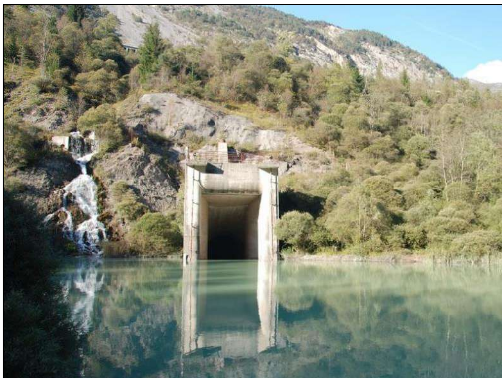
Figura 35: L'attuale imbocco galleria posto a quota 635 m s.l.m.
