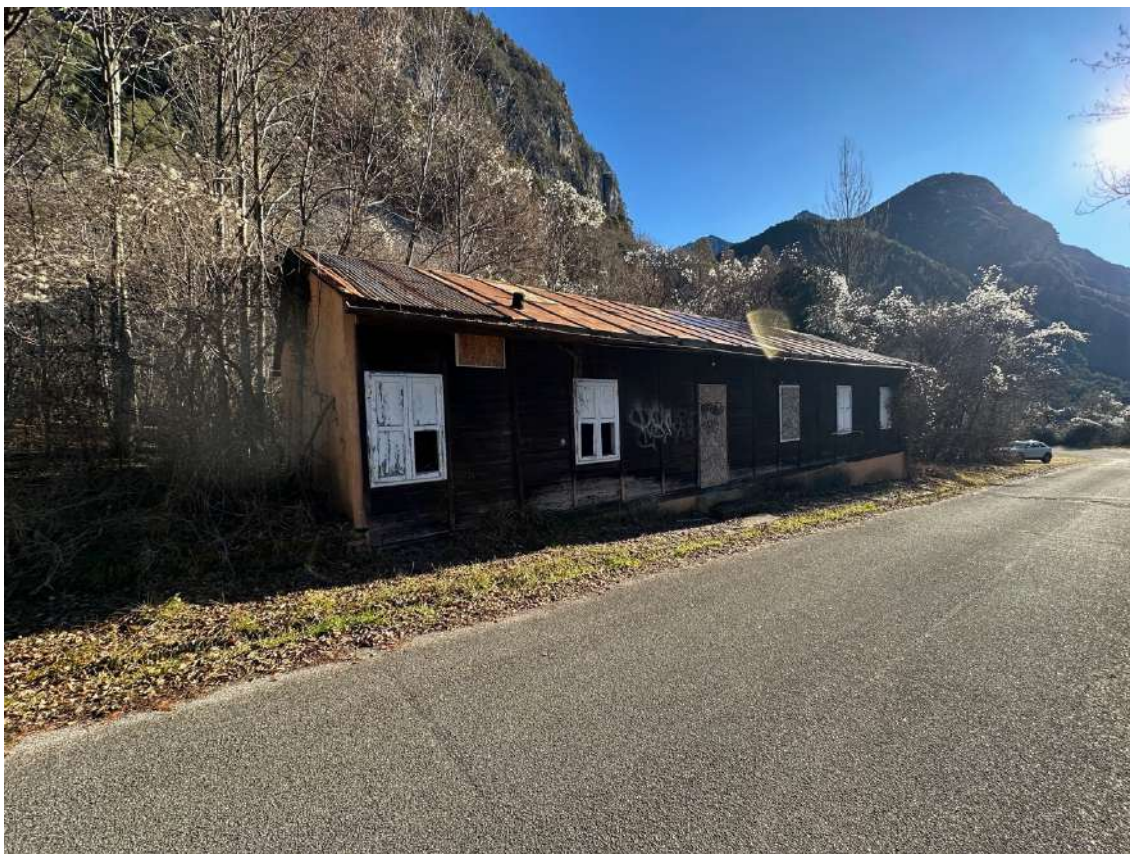
FIGURA 50: Edificio esistente dove è previsto inserire la cabina di MT punto di consegna. L'immobile verrà riqualificato con le medesime caratteristiche.
