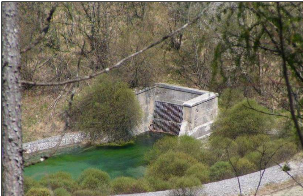
Figura 31: Imbocco attivo galleria quota 640 m s.l.m.
