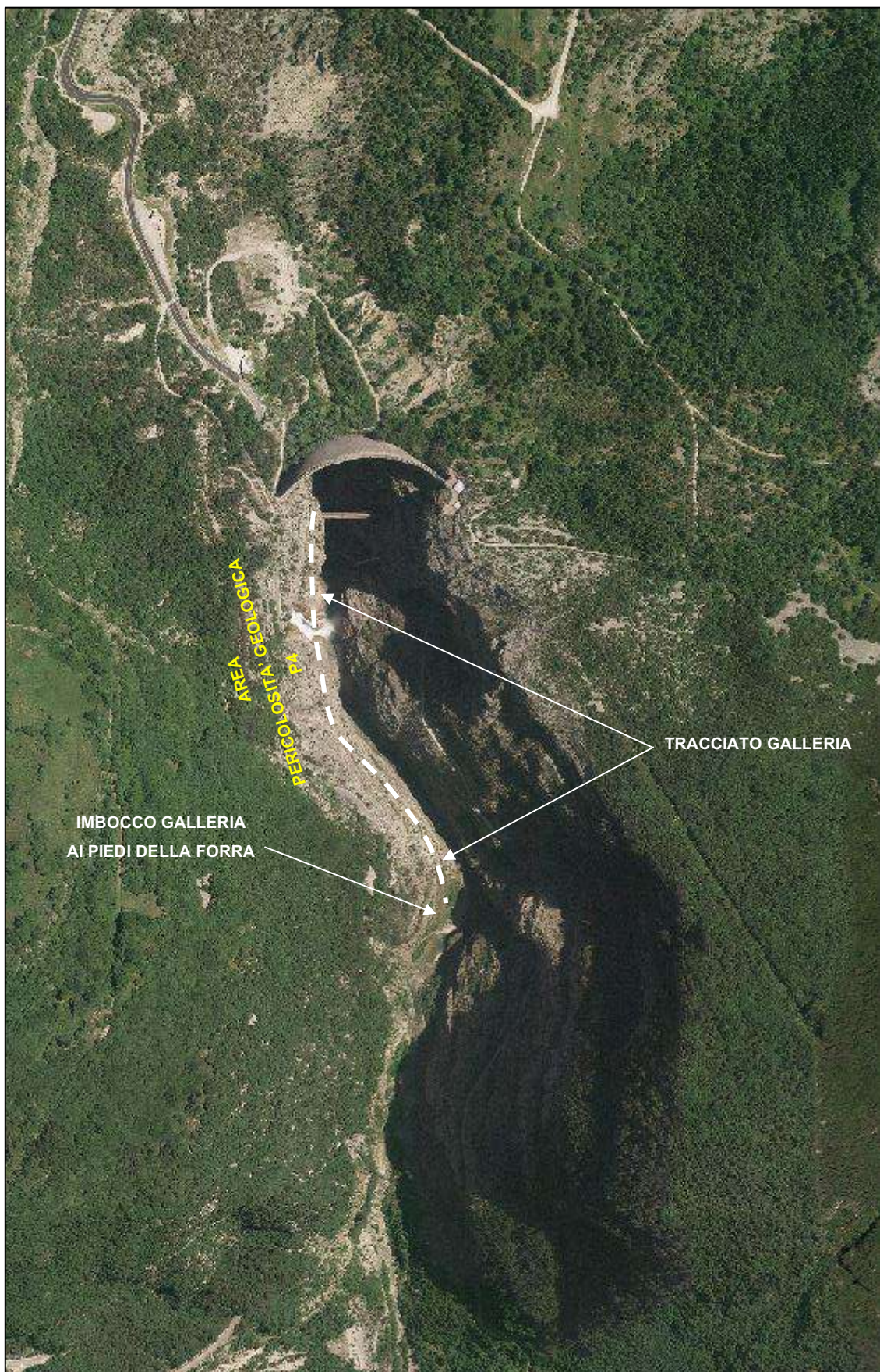
Figura 10: Primo piano dell'area perimetrata "P4" in destra idrografica a valle della diga del Vajont: in evidenza il punto di imbocco ed il tracciato della galleria realizzata ai piedi della forra (1956÷1957) in funzione della costruzione della diga del Vajont.
