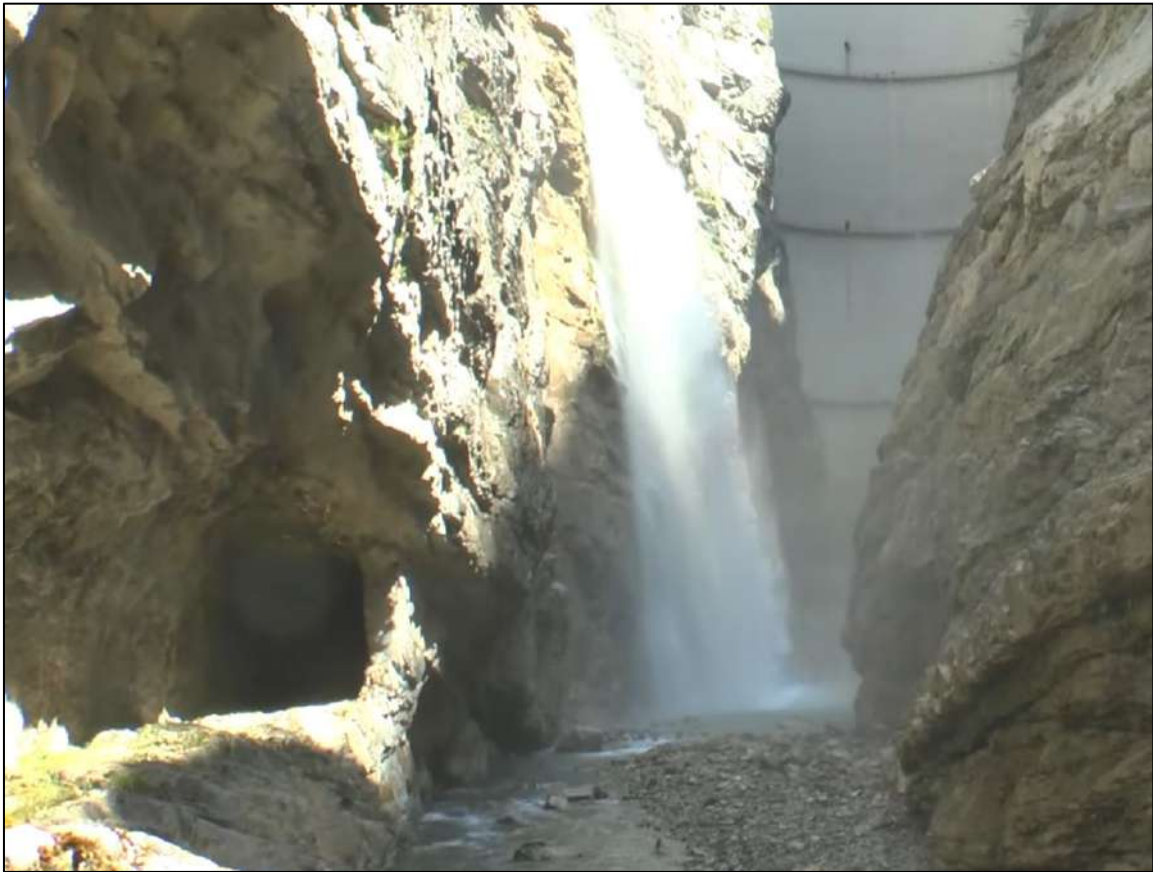
Figura 11: Primo piano galleria presente in destra idrografica in corrispondenza dell'area perimetrata "P4": zona cascata galleria by-pass.
